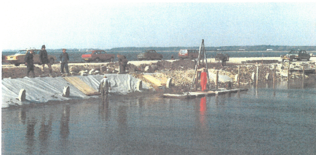
Her arbejdes på at sikre broen
